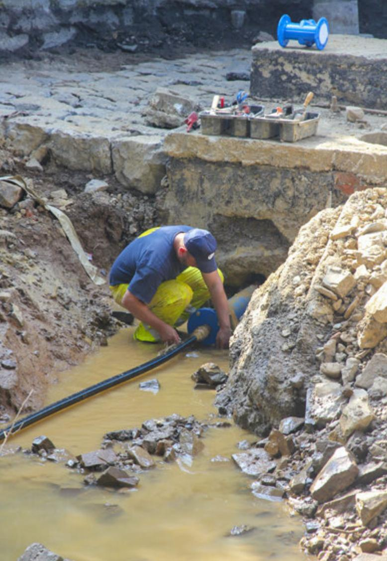
tection contre le gel, est enterré à un mètre de profondeur, ce qui l'a relativement protégé des dégâts. Ce n'est pas le cas sous les ponts où nos conduites ont été arrachées par la force du courant. Notre objectif prioritaire a donc été de rétablir un maximum de connexions en posant des conduites provisoires avec des protections contre les rigueurs de l'hiver à venir.
